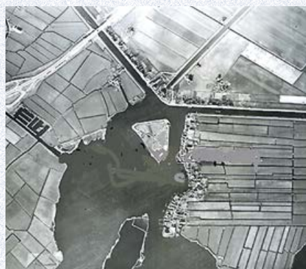
RAF-Luchtfoto van de Kagerplassen, 25 februari 1945. Duidelijk zichtbaar linksboven de nieuwe Rijksweg met Kaagbrug over de Ringvaart en gemaal De Leeghwater.
